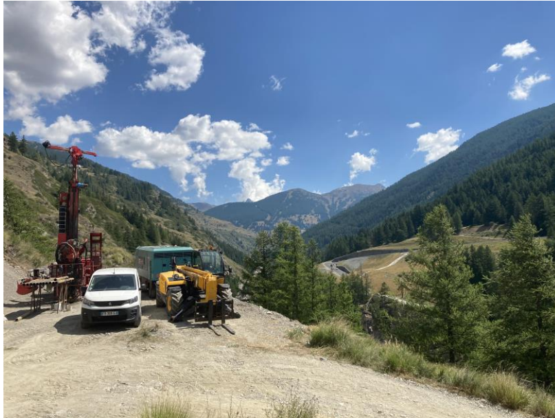
Réalisation d'un forage sur le Glissement du "Pas de l'Ours" à Aiguilles (Hautes-Alpes) ©BRGM
