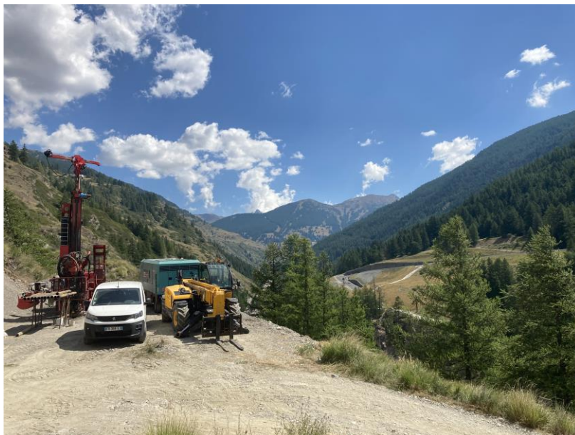
Realizzazione di una perforazione sul frane di scivolamento del "Pas de l'Ours" a Aiguilles (Hautes-Alpes) ©BRGM
